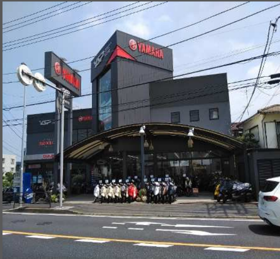
改修工事後の外観
