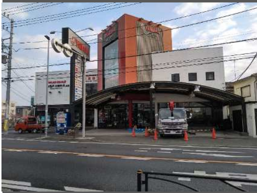
改修工事前の外観
